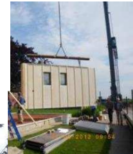
Murs préfabriqués avec isolation intégrée
