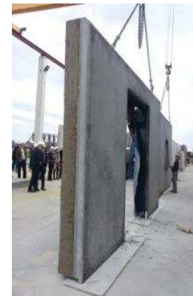
Murs préfabriqués avec isolation intégrée
