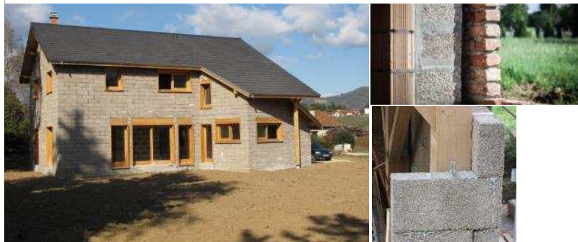
Blocs préfabriqués en remplissage
